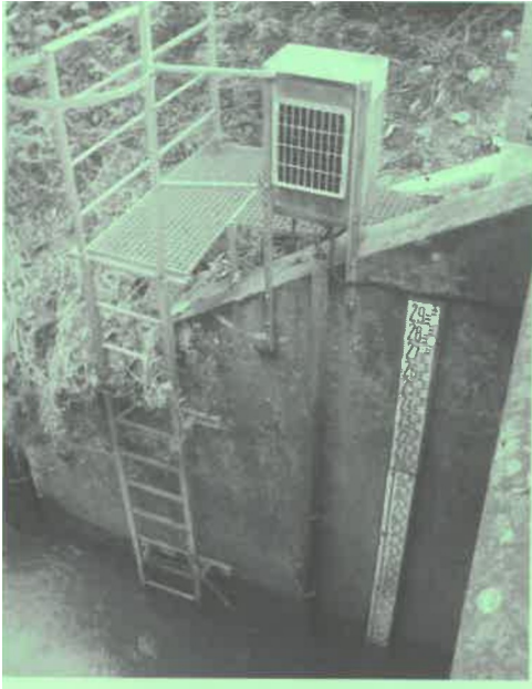
Fig. 2 : la station de collecte de Wirwignes
